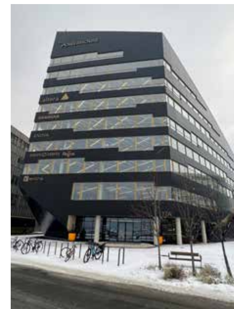
Mens de venter på at deres nye lokaler skal bli ferdige, holder Wiersholm til i Powerhouse, noen hundre meter unna Tollboden.
